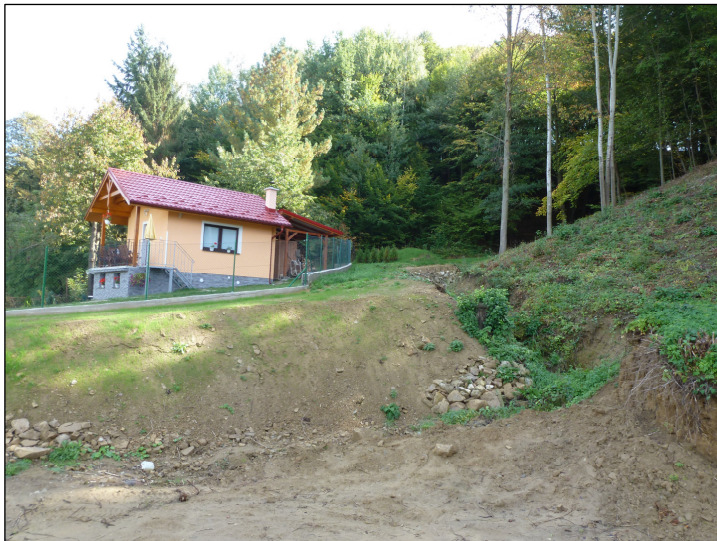
Obr. 3.6-4. Dejekčný kužel' s hlinito-piesčitým až piesčito-kamenitým materiálom a nevhodne umiestnenou stavbou rodinného domu v Chrenovci.
