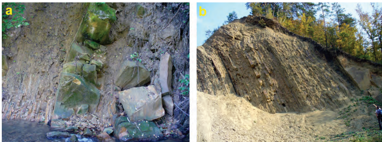
Obr. 20. Bystrická jednotka: a – pieskovcová fácia (37) belovežského súvrstvia južne od Andrejovej (foto M. Kováčik); b – drobnorytmický flyš (36) belovežského súvrstvia, opustený lom pri Dubinnom (foto M. Kováčik).
