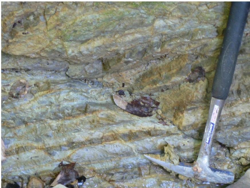
Foto 13. Striedanie pestrých vrstiev belovežského súvrstvia. Bystrická jednotka, d. b. NBŽ-1957, bočný prítok potoka Luh, na JZ od Ladomirova (foto B. Žec).
