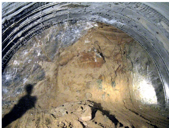
Obr. 9.5. Výplň krasovej kaverny a charakter hornín na čelbe železničného tunela Turecký vrch (výška čelby je 6 m) (Teťák, 2016).
