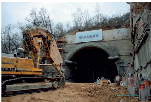
Obr. 8.14. Severný portál železničného tunela Turecký vrch (Tisaj et al., 2011).
