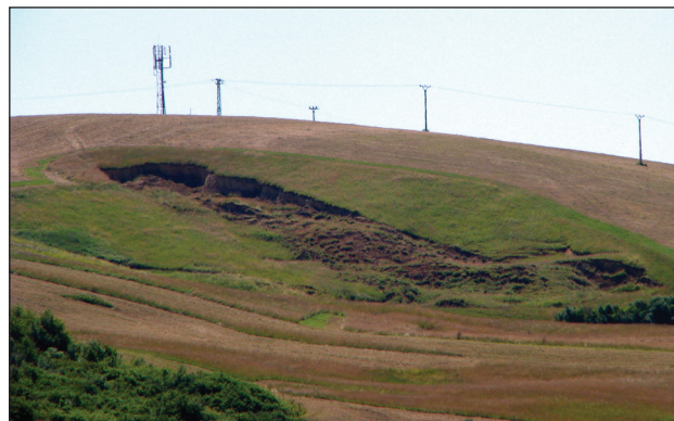
Fig. 3. Landslide Lužany pri Topli.
