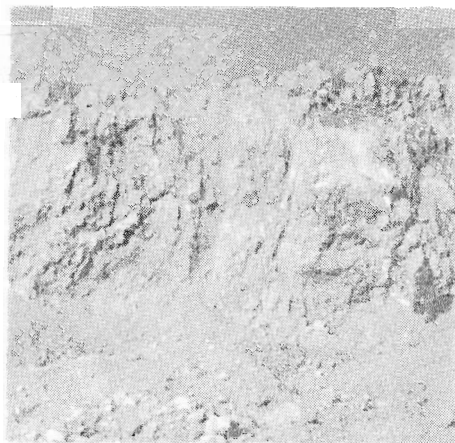
Foto 1. Stupeň porušenia vápencov vo východnej stene hornej nádrže Photo 1. Grade of limestone disruption in the east wall
