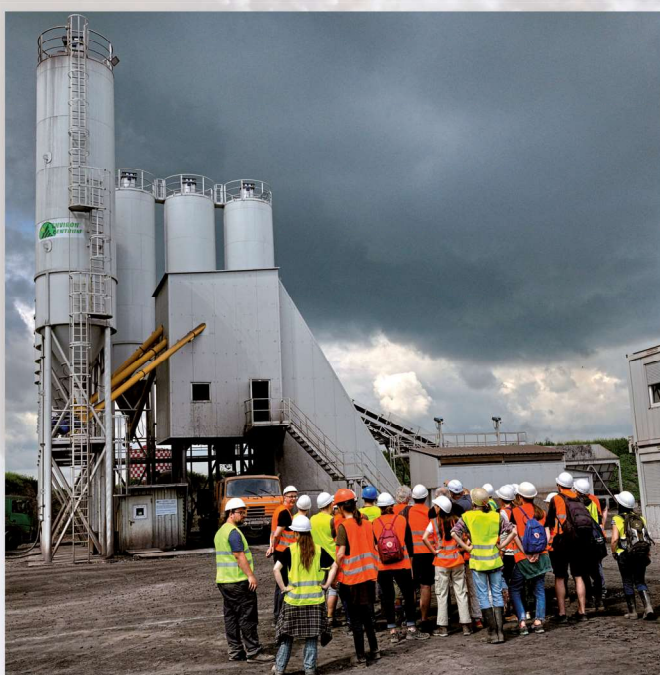
Solidifikačná linka na technologickú úpravu nebezpečných odpadov (ENVIRONCENTRUM, s.r.o. Košice) (foto: P. Sekula)
