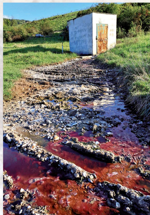
Priesakové vody - sanácia EZ ZH (015) / Žiar nad Hronom – stará skládka PO ZSNP (foto: Ľ. Jurkovič)
