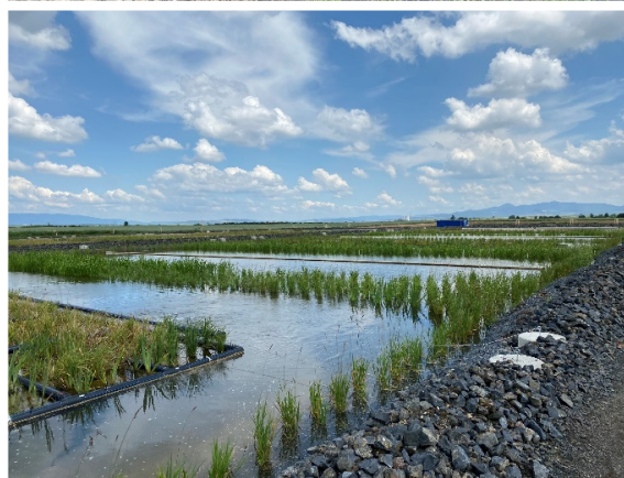
Obr. 3 Vzhled nádrží A1 a B1 v červnu 2020 při spuštění zkušebního provozu
