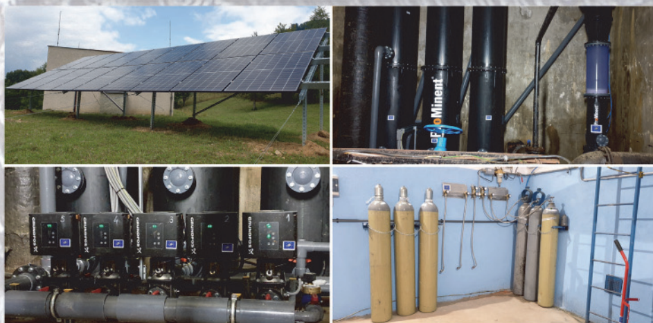
Rekarbonizačné zariadenie na obohacovanie pitnej vody (vodný zdroj Kokava nad Rimavicou, viac v príspevku Rapant a kol. v tomto zborníku, foto: V. Cvečková)
