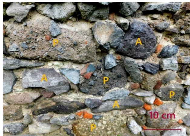
Obr. 2 Kláštorné murivo: andezity (A) a pyroklastický materiál (P)
