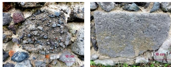
Obr. 4 Typy pyroklastického stavebného materiálu: a) hrubozrnný a b) jemnozrnný
