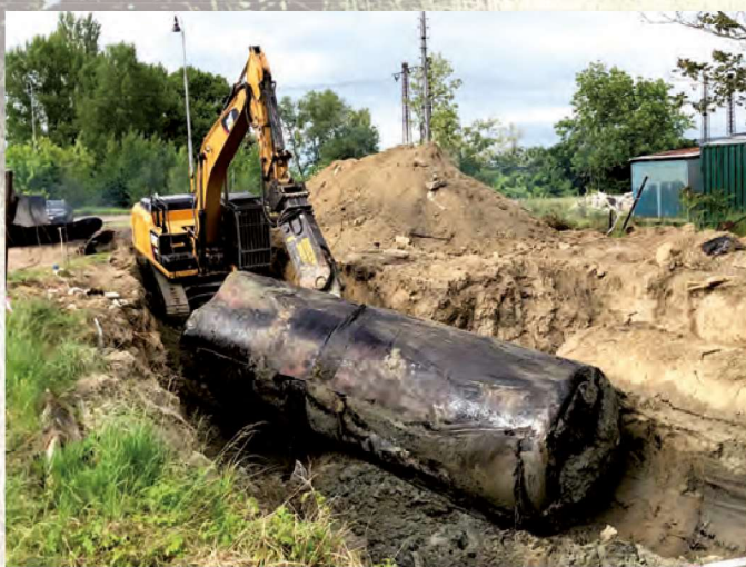
Odstaňovanie zdroja znečistenia - podzemných zásobníkov pohonných hmôt (foto J. Macek)
