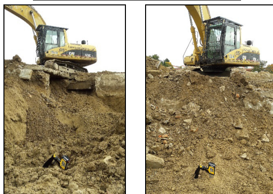
Obr. 6 Odtěžba kontaminované zeminy kontrovaná pomocí ED-XRF spektrometru DELTA
