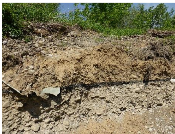
Obr. 3 Zasypaná vrstva odpadového troskového materiálu. Dubnica nad Váhom.
