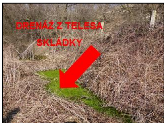
Obr. 6 Drenáž kontaminovaných vôd zo západnej steny telesa skládky, dokumentačný bod PV148-41.
