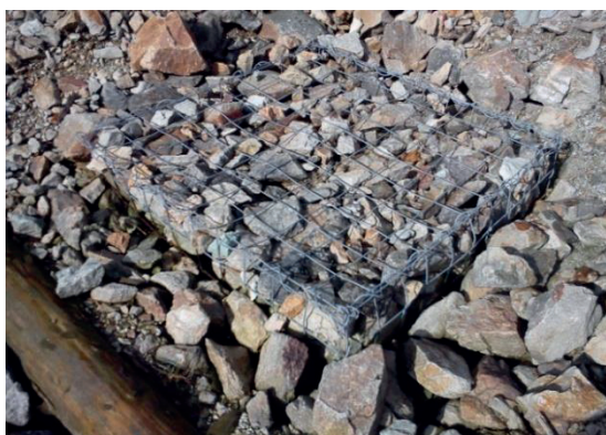
Obr. 1 Fe^0 -bariéra na haldovom poli Podlipa
