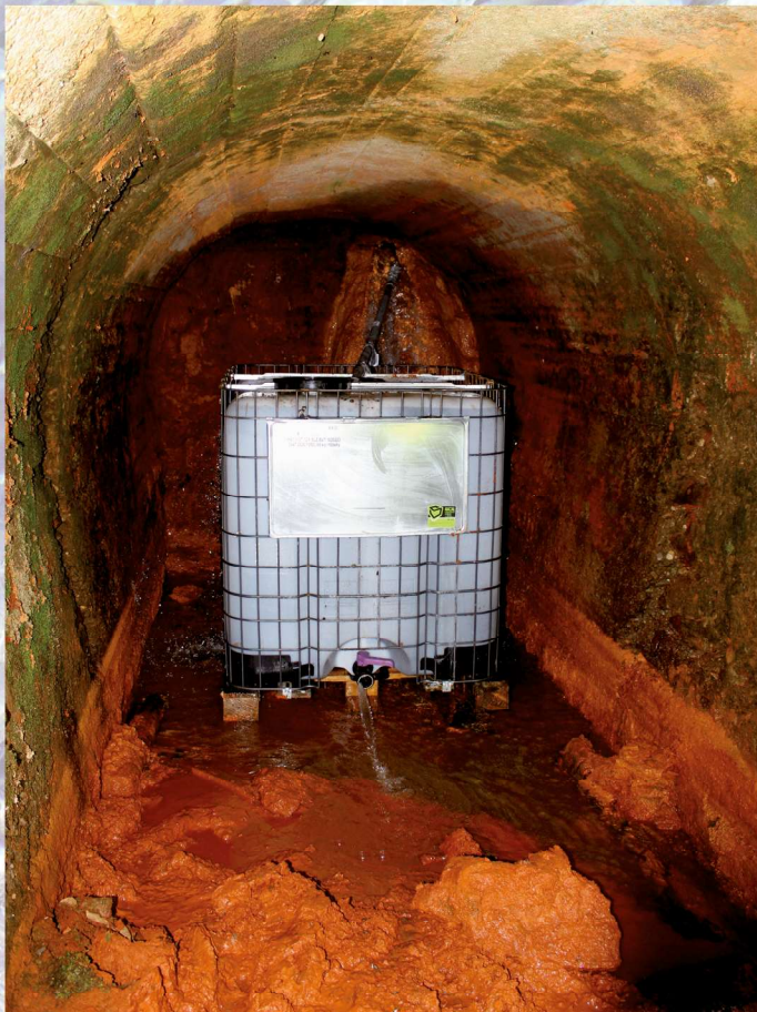
Pilotný pasívny systém na čistenie banských vôd (štolňa Agnes, Poproč) (foto: L. Jurkovič)
