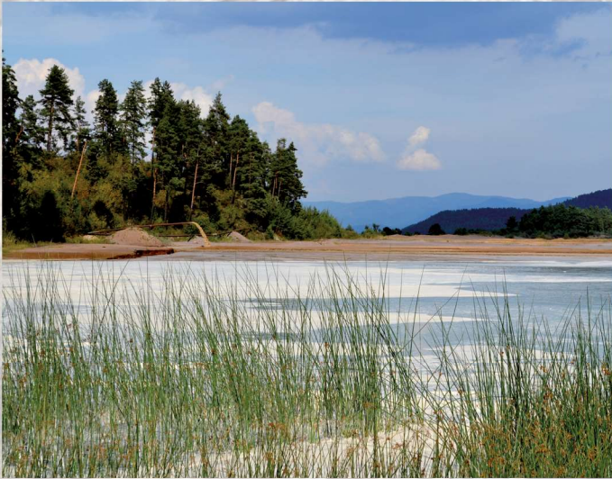
Pohľad na odkalisko Markušovce. Foto: R. Tóth
