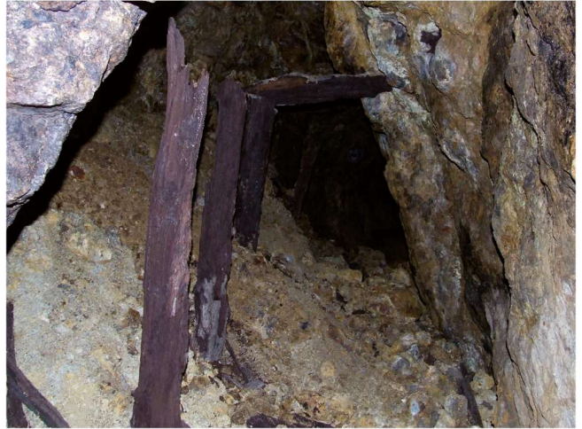
Opustená štôľňa po ťažbe Au – Telkibanya (HU) (foto: Ľ. Jurkovič)
