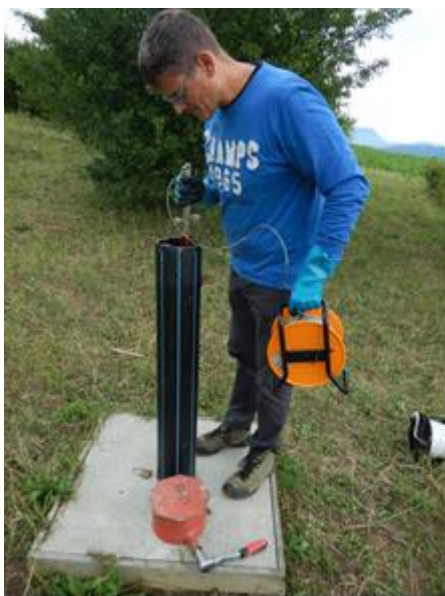
Revízia inklinometrického vrtu IGI-04 na lokalite Liptovská Štiavnica
