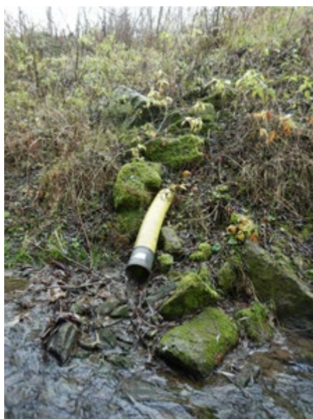
Revízia stavu drenážno-stabilizačného rebra na lokalite Babín – vyústenie odvodnenia.
