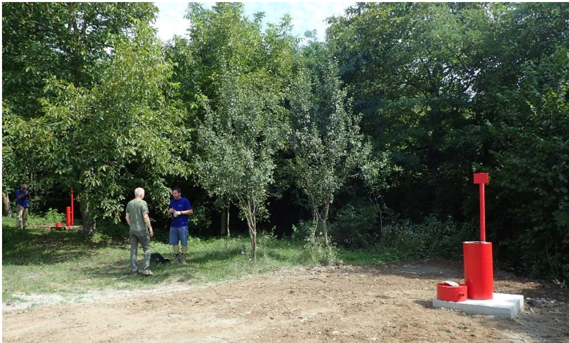
Zabudovaná dvojica pozorovacieho a exploatačného hydrogeologického vrtu RKP3-3 na lokalite Vyšné Valice
