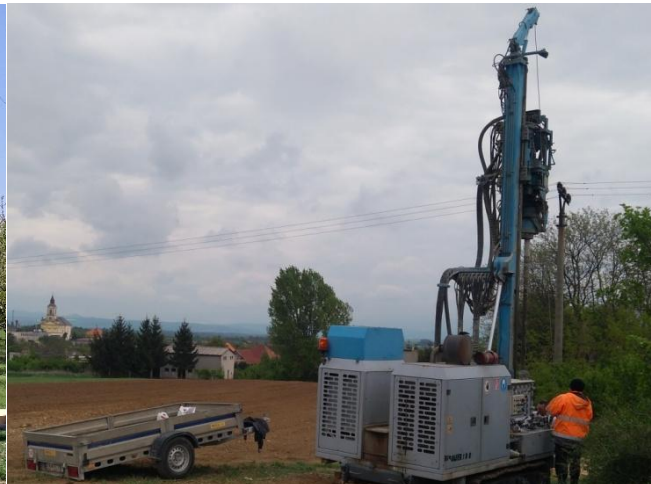
Vŕtanie vrtu PN-2 (Svodín) vrtnou súpravou Prakla RB-8
