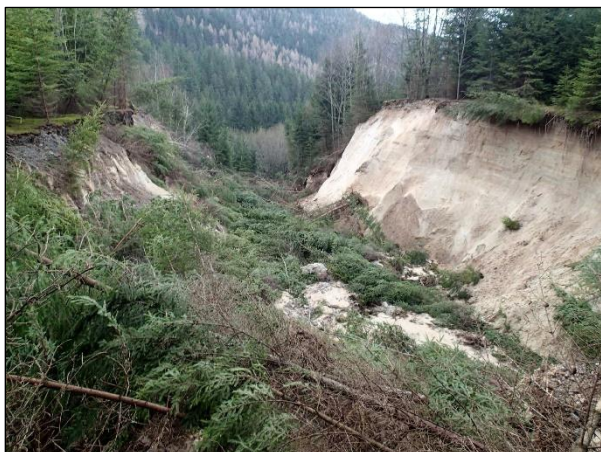
Vznik svahovej deformácie na odkalisku Lazisko – Dúbrava č. 2, bočná severovýchodná stena odlučnej časti svahovej deformácie
