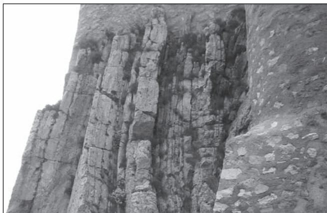
Obr. 3. Hrad Beckov – záverečná zastávka predkonferenčnej exkurzie. Na vztýčených laviciach sivého vápenca (mixtitu) partnašských vrstiev hronika sa buduje stiborovská bašta.
