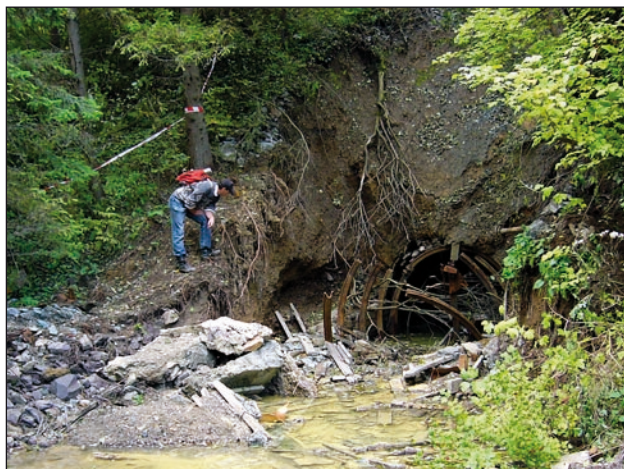
Obr. 14. Dôsledky prievahu banskej vody z Novej štôľne v lokalite Novoveská Huta – Teplička. Vľavo: poškodené ústie štôľne s erodovaným úvodným úsekom. Vpravo: eróziou poškodená miestna cesta a koryto potoka zanesené naplaveným materiálom. Foto Baláž, 2. 10. 2008.
