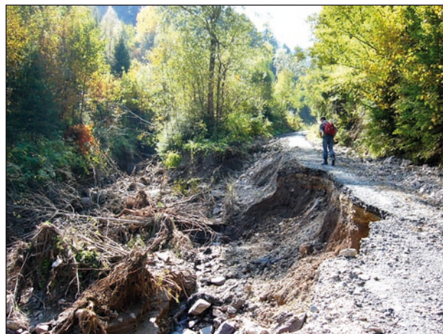
Obr. 14. Dôsledky prievahu banskej vody z Novej štôľne v lokalite Novoveská Huta – Teplička. Vľavo: poškodené ústie štôľne s erodovaným úvodným úsekom. Vpravo: eróziou poškodená miestna cesta a koryto potoka zanesené naplaveným materiálom. Foto Baláž, 2. 10. 2008.
