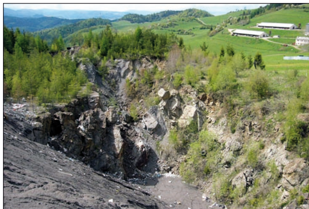
Obr. 3 (vľavo): Závalové pásmo Baniská, pohľad zo starej prepadnutej cesty na Poráč smerom na západ (foto Baláž, 12. 5. 2005).
