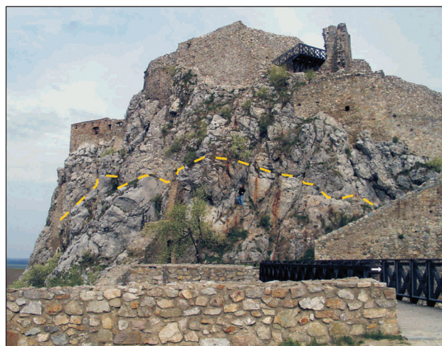
Obr. 2b. Pohľad na citadelu Devínskeho hradu od Garajovského paláca (k východu). Spodnú časť steny brala tvorí dolomitová brekcia, vrchnú plešská brekcia.
