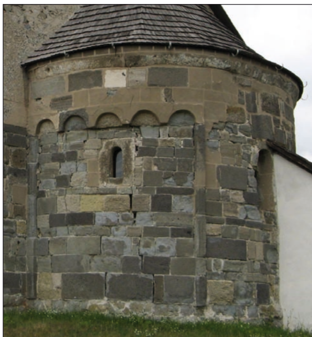
Obr. 5. Románska apsida kostola v Kalinčiakovke postavená z kvádrov neogénnych tufitov.
