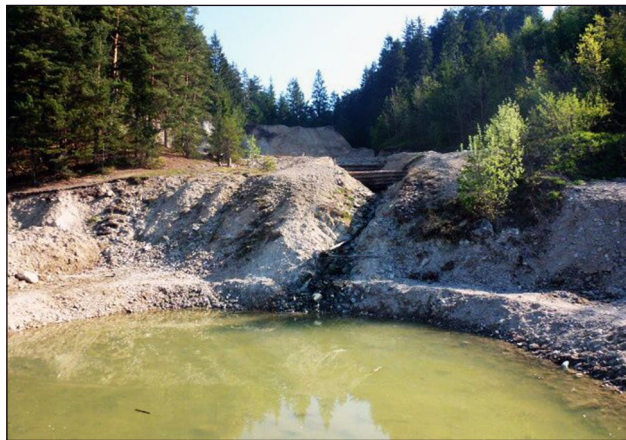
Obr. 17. Retenčná nádrž pod haldovým poľom Podlipa.
