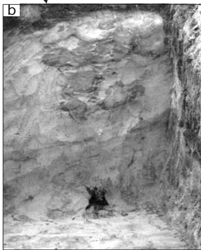
Obr. 6. Odkalisko Sedem žien (stav z júla 2003). a – zvrstvenie sedimentov vrcholovej časti náplavového kužela havarijného vtoku rmutu, b – čelo sondy vo svahu 7. etáže hrádze, c – výkveti sírnatých solí na čelnej strane sondy (b) po siedmich bezzrážkových dňoch od jej vyhlbenia.
