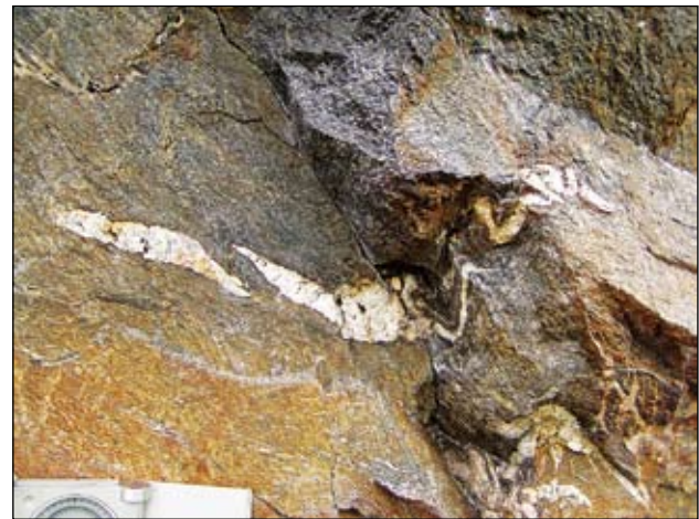
Obr. 5. Deformovaný granitoid z Bacúšskej doliny severne od Bacúcha.
