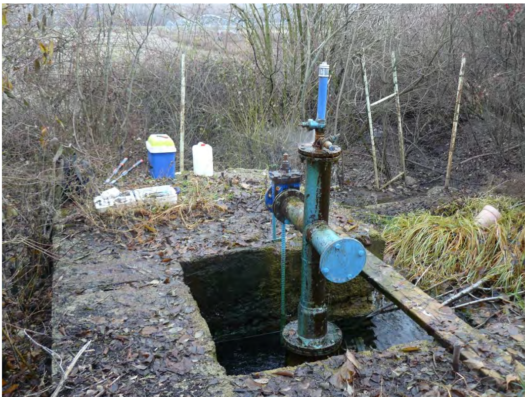
Geotermálny vrt FGKr-1 Kravany n. Dunajom
