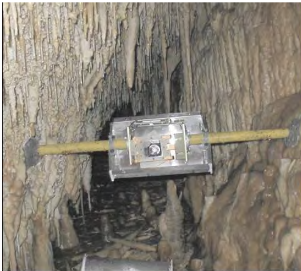
Inštalácia dilatometra TM-71 v Čarovnej chodbe (Demänovská jaskyňa Slobody)
