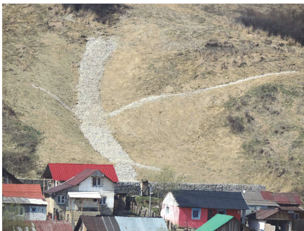
Pohľad na zrealizované drenážno–stabilizačné rebro
