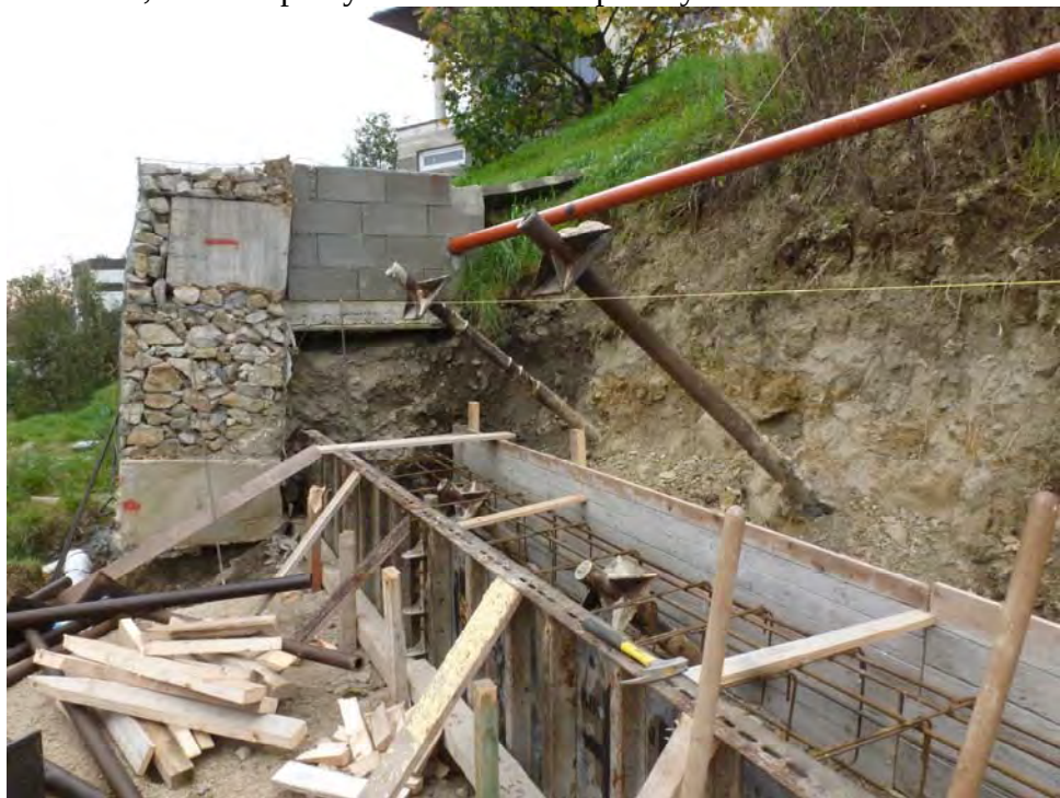
Realizácia kotveného oporného múru v obci Šenkvice
