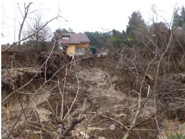
Banka Piešťany - Pohľad na zosun a na chatu č. 657 z prístupovej cesty
