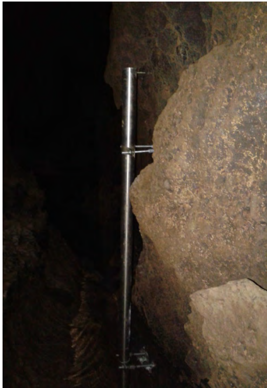
Inštalované monitorovacie zariadenia pre sledovanie parametrov vody v Krásnohorskej jaskyni
