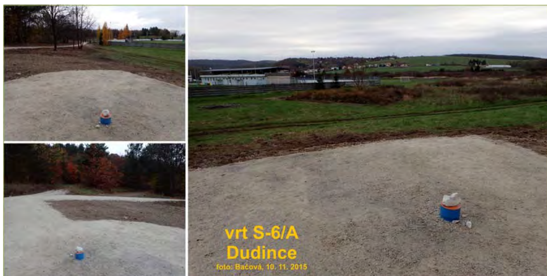
Pohľad na nový hydrogeologický vrt vyhl'bený v Dudinciach v roku 2015 – vrt S-6/A (12 m)
