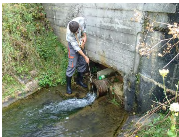
Meranie prietoku na výtoku z Novej odvodňovacej štolne v rámci projektu ISSOP
