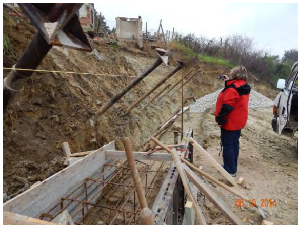
Sanačné práce v obci Šenkvice
