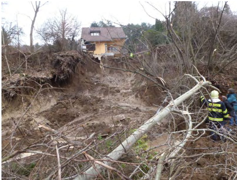
Realizácia okamžitých protihavarijných opatrení s cieľom zabezpečenia stability havarijného zosuvu v Banke.
