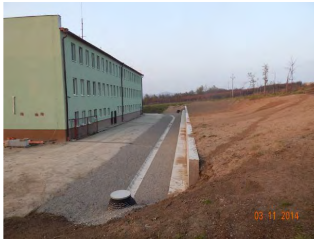
Kotvená pilótová stena nad základnou školou v obci Nižná Myšľa
