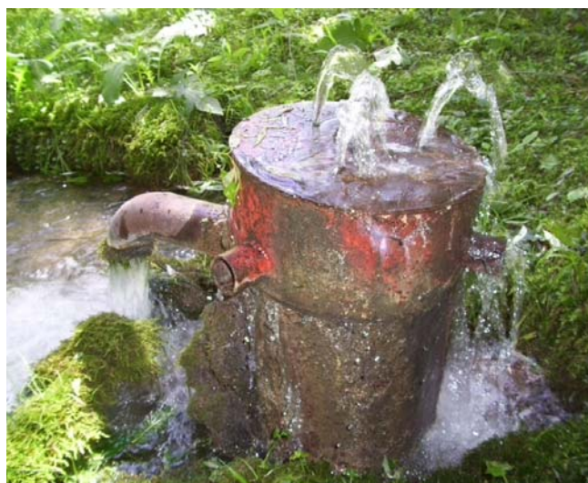
Zhlavie hydrogeologického vrtu v pramenisku Teplica v Kunovej Teplici po povodniach v júni 2010 (foto P. Malík).
