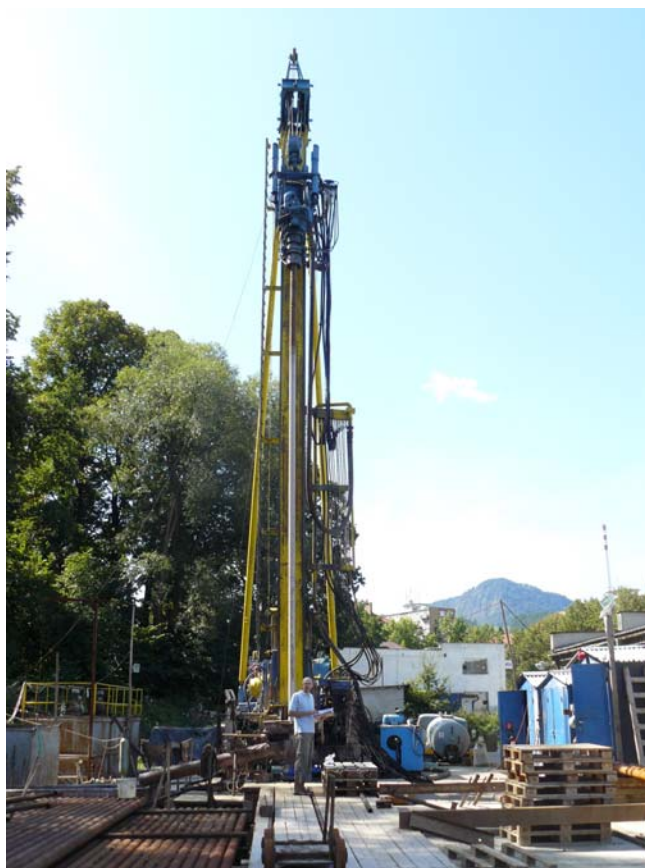
Vŕtanie hydrogeologického vrtu RH-1 v Handlovej – zodpovedný riešiteľ RNDr. Radovan Černák (foto F. Bottlik).
