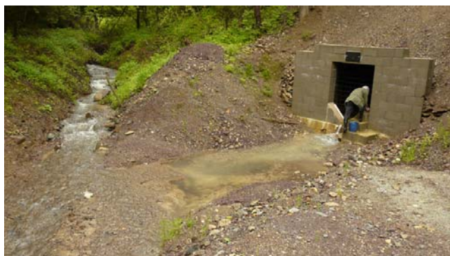
Merania prietoku výtoku banskej vody z ústia Novej štôlne, lokalita Novoveská Huta (foto P. Bajtoš).
