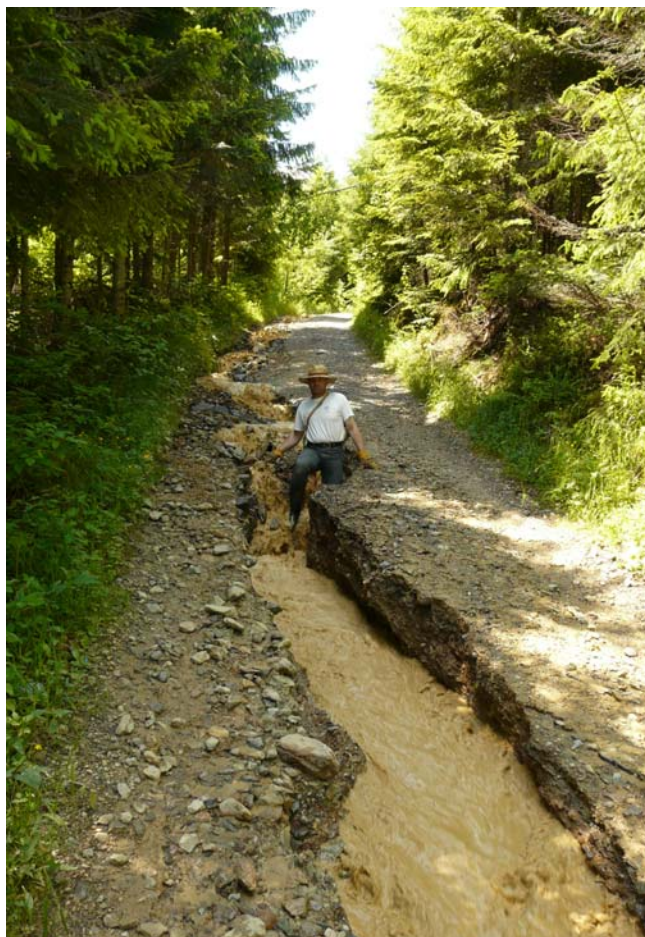
Vplyv ťažby nerastov na životné prostredie: ryha v lesnej ceste vzniknutá intenzívnou mechanickou eróziou prúdu banskej vody vytekajúcej z krátera nad ústím Novej štôlne počas kulminácie jej výdatnosti po extrémnych zrážkach v júni 2010, lokalita Novoveská Huta (foto P. Bajtoš).
