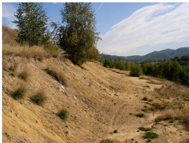
Odkalisko Sedem žien – ukážka nedostatočnej rekultivácie.
