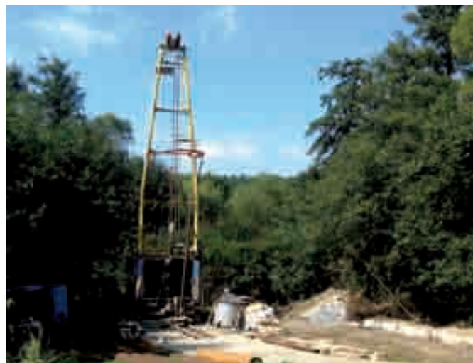
Vrtanie hydrogeologického vrtu ČH-1 (Malá Čausa, Handlovská kotlina) s celkovou hĺbkou 151,5 m. Foto: Radovan Černák.
