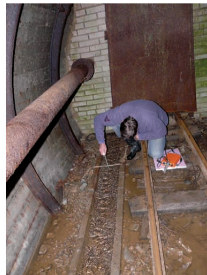
Meranie prietoku banskej vody v štolni Martin, Sb ložisko Dúbrava, Nízke Tatry. Foto: P. Bajtoš
