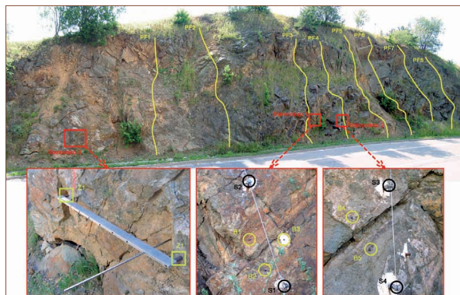
Rozmiestnenie pozorovaných profilov a bodov na monitorovanom úseku zárezu cesty pri Banskej Štiavnici. PF1 až PF8 – profily pre stereofotogrametrické merania, Stanovisko 1 a 2 – pozorovacie body pre merania dilatometrom Somet (body B) a pre merania meradlom posuvov (body S), Stanovisko 3 – body na upevnenie meradla mikromorfologických zmien povrchu skalnej steny, pomocou ktorého sa pozoruje vývoj zvetrávania skalného masívu
