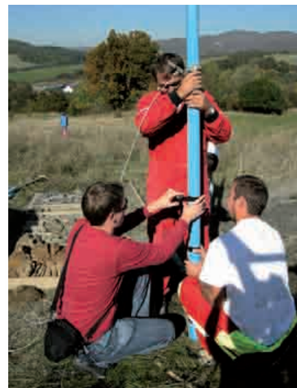
Vystrojovanie inklinometrického vrtu KI-1 na lokalite zosuvu vo Veľkej Čause, v pozadí vrt AH-1 s automatickým hladinomerom a zrážkomerom. Foto: D. Sitányiová, október 2008
