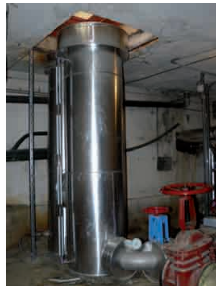
Hydrogeologické vrtý VLÚ-1 a V-4A zachytávajúce minerálne liečivé vody v Piešťanoch. Foto: D. Marcin
