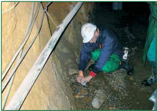
Mgr. Černák vzorkuje prítoky podzemnej vody v tuneli Višňové. Foto P. Malík.
