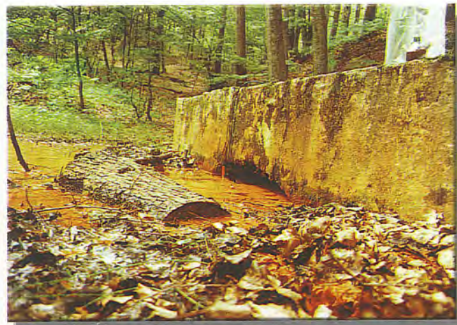
Kalom zanesené ústie štólne Agneška (Sb rudy), Poproč. Foto: P. Baláž Mud deposited at the adit of the Agneška gallery (Sb ores), Poproč. Photo: P. Baláž
