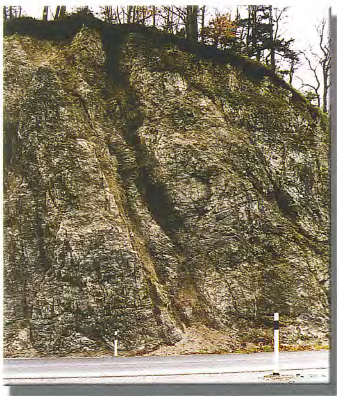
Zvetrávaním a eróziou vypreparovaná tektonická porucha v dolomitoch v záreze cesty Harmanec – Šturec. Foto: P. Liščák
